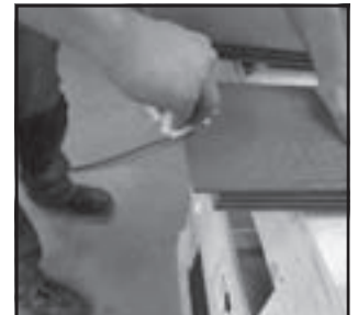
8 - Verwijder gelijk overtollige verf op het zichtvlak
