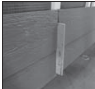
10 - gebruik een mal om de afstand (8mm) te hanteren, vul de dilatatie ruimte slagregendicht af
