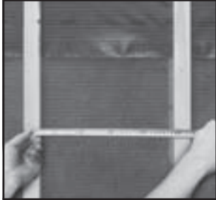
1 - Aanbrengen regelwerk h.o.h. afstand maximaal 600 mm
