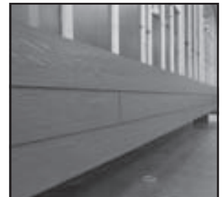
12 - Aanbrengen 3 de laag, enz.
