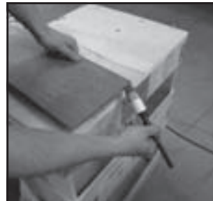
7 - Zaagkanten 2 maal sealen met retoucheerverf
