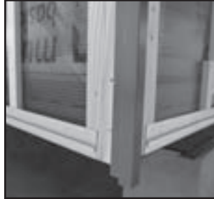
2 - Aanbrengen start, ventilatie en buitenhoek Alu / PVC profiel
