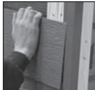
11 - Corrigeer tijdens montage de plank zodat deze aansluit op het onderliggende deel
